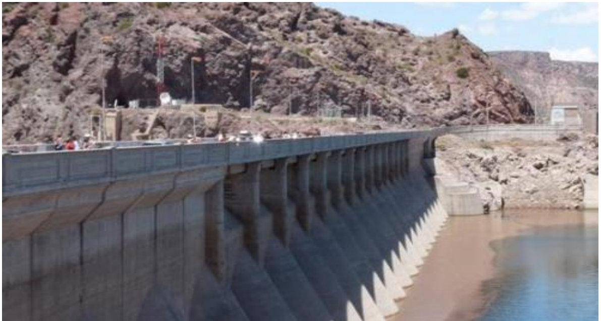
Figura 9 - Barragem de contrafortes de Valle Grande, no rio Atuel, San Rafael, Argentina
