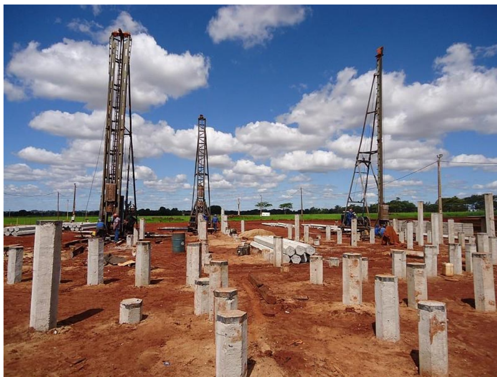
Figura 7 – Cravação de estaca pré-moldada
