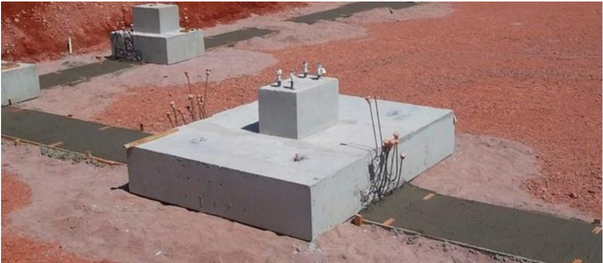
Figura 6 – Sapata isolada
