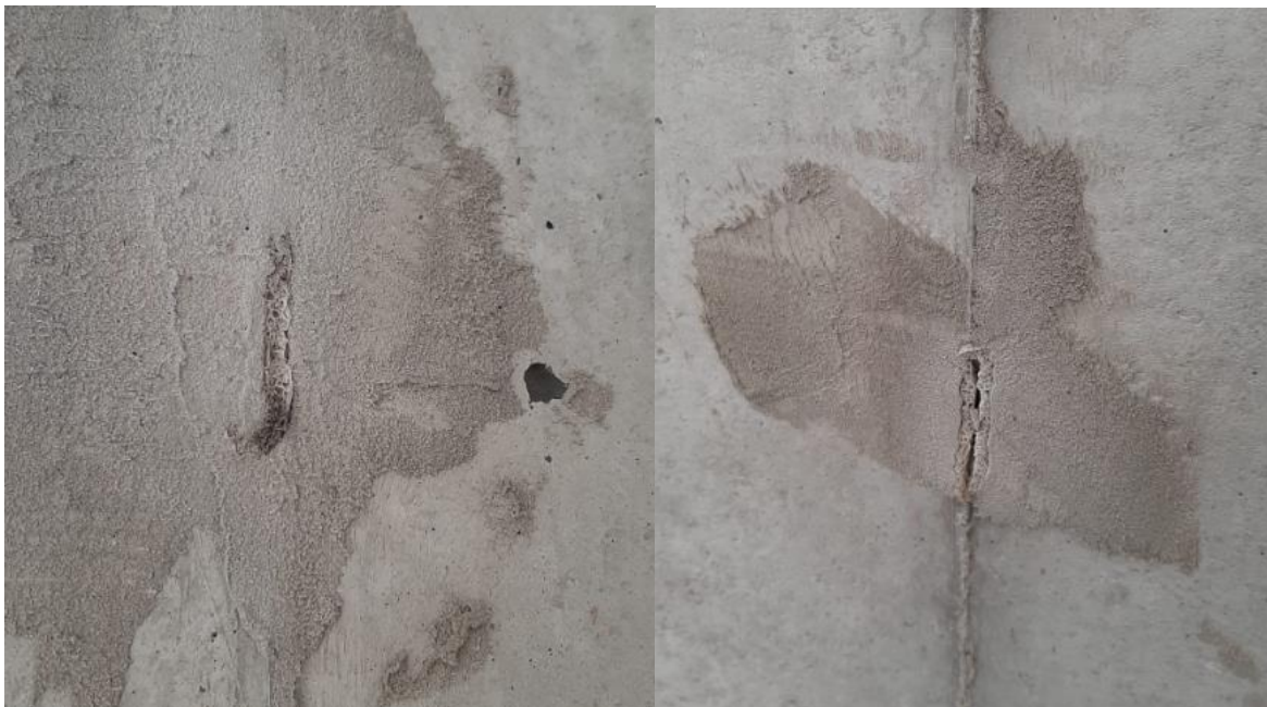
Figura 22 - Camisa de faqueta presente na parede após a estucagem
