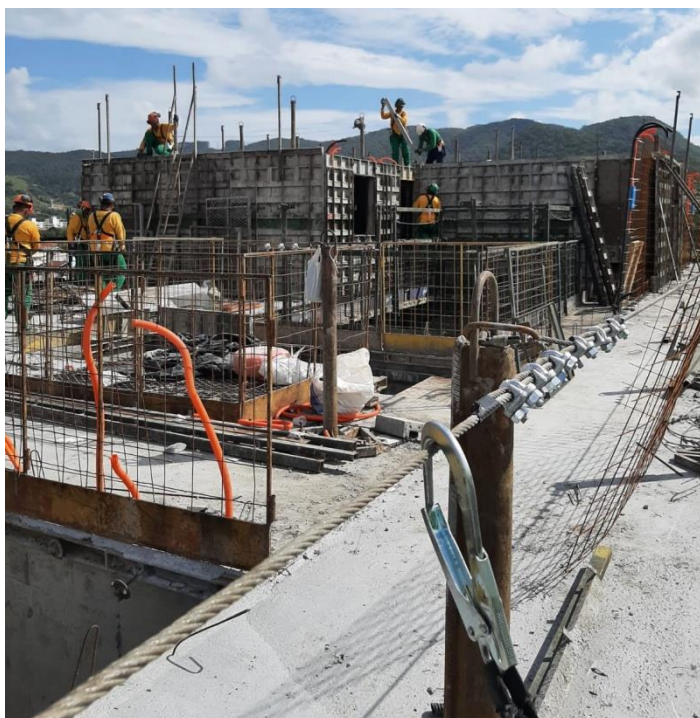
Figura 16 - Instalação das formas metálicas e posicionamento da armadura e eletrodutos das paredes
