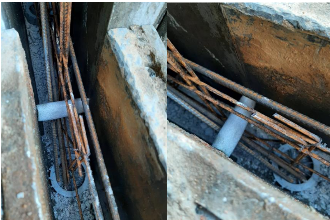
Figura 21 - Presilha de travamento das formas posicionada na parede antes da concretagem
