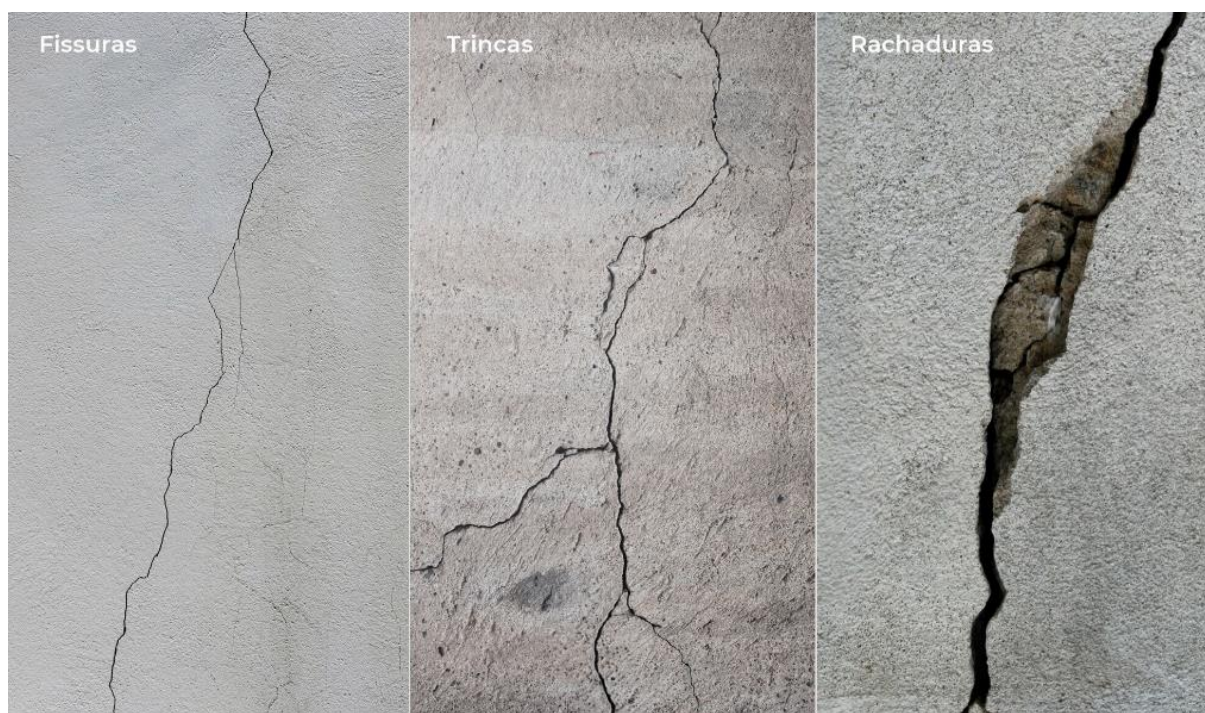
Figura 7 - Diferença entre trinca, fissura e rachadura
