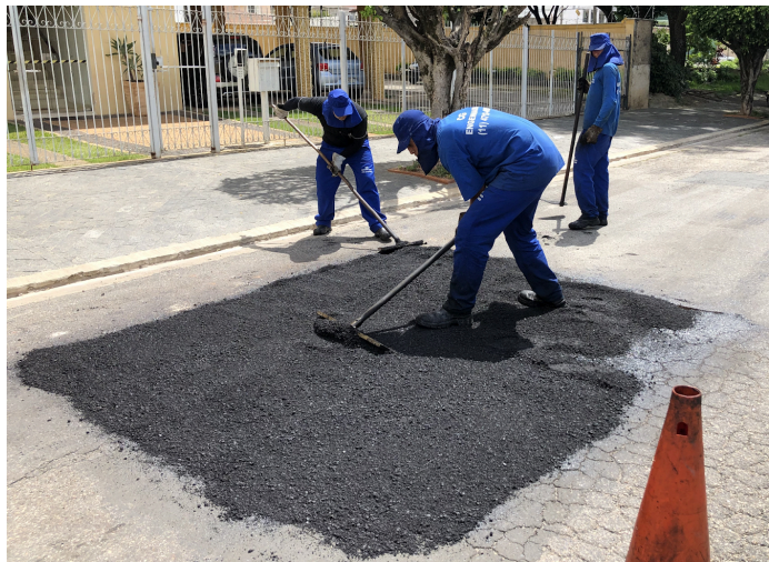
Figura 30 - Espalhamento do agregado
