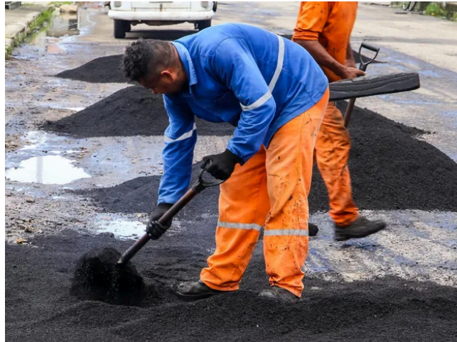
Figura 29 - Enchimento da caixa
