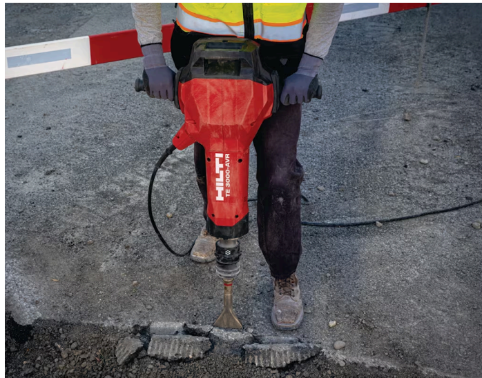
Figura 31 - Corte do material degradado
