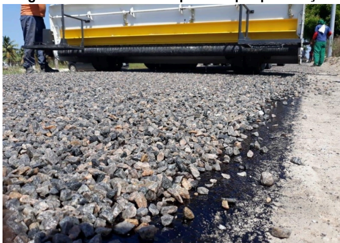
Figura 03 - Tratamento superficial por penetração
