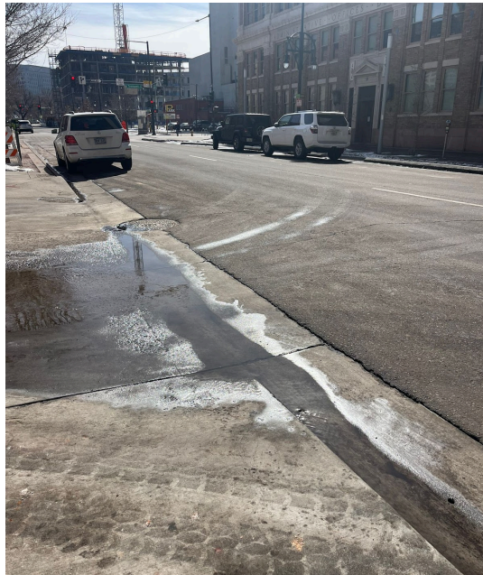
Figura 26 - Empoçamento de água
