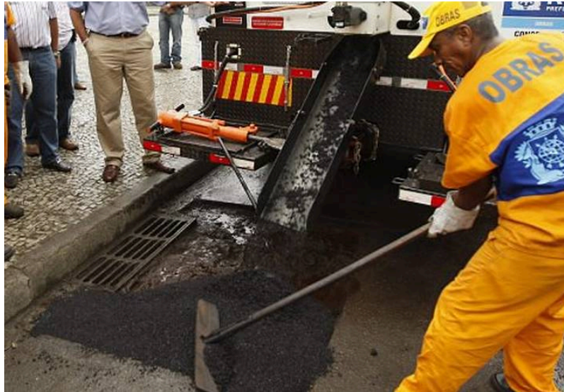
Figura 32 - Colocação da mistura betuminosa
