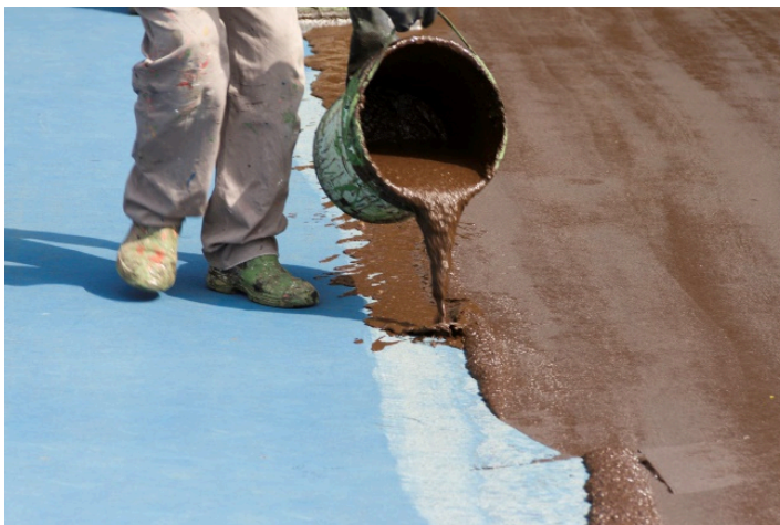
Figura 05 - Aplicação de lama asfáltica
