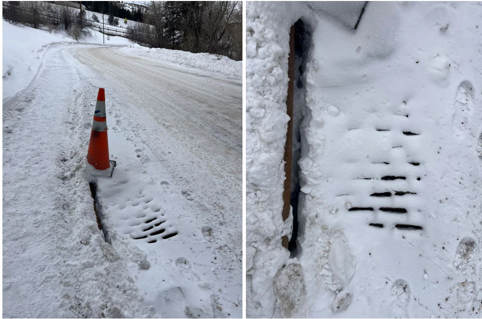
Figura 25 - Boca de lobo obstruída
