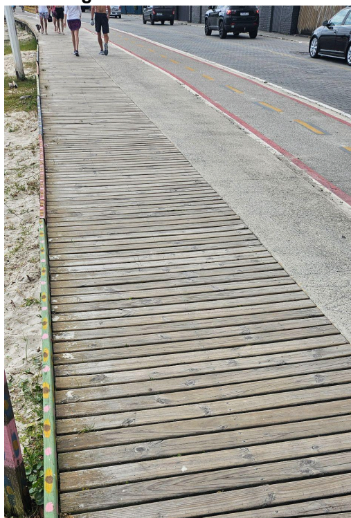
Figura 14 - Piso de madeira
