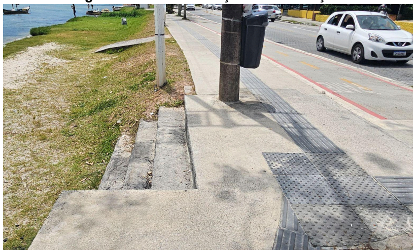
Figura 28 - Escada avançando sobre calçada
