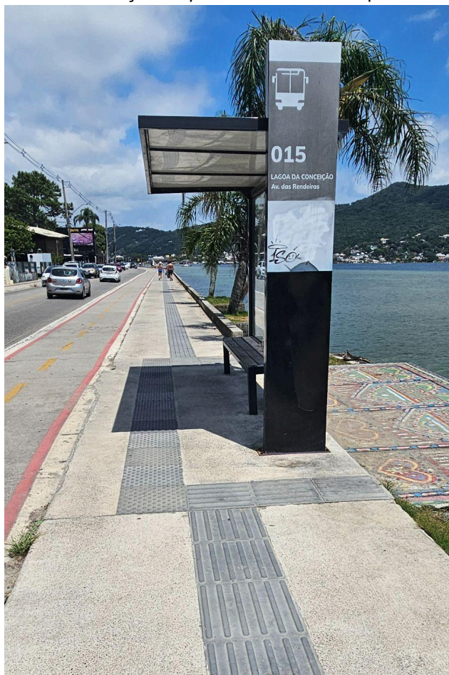
Figura 26 - Descontinuidade da guia de balizamento no trecho; e sinalização do ponto de ônibus adequada
