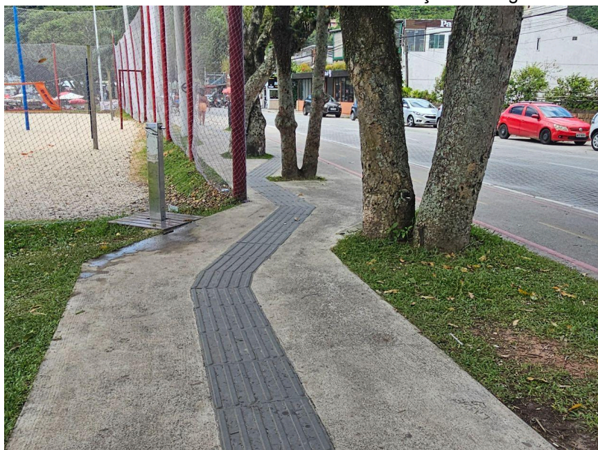
Figura 42 - Recomenda-se a continuidade da faixa de serviço e o alargamento da calçada
