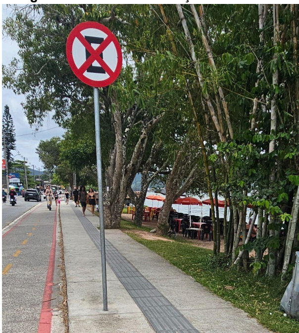
Figura 37 - Falta de sinalização em obstáculo
