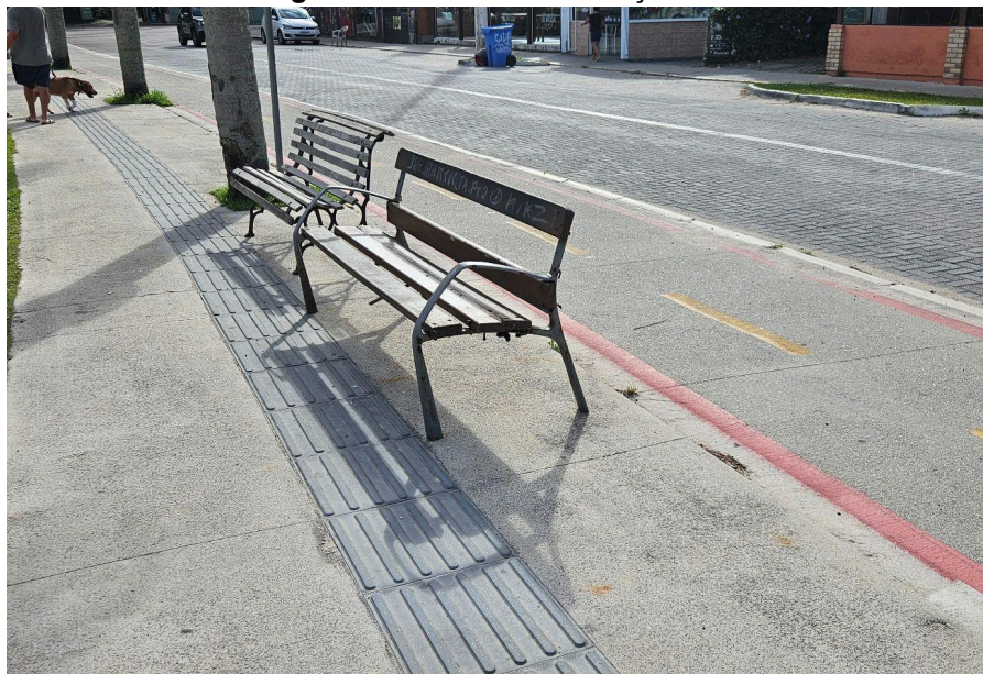
Figura 43 - Falta de sinalização em obstáculo
