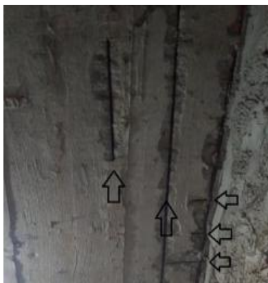
Figura 14 - Representação de corrosão de armadura
