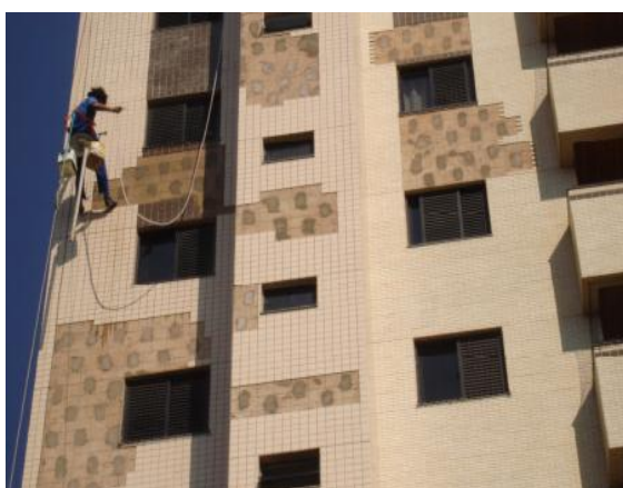
Figura 16 - Representação de manifestações patológicas no revestimento cerâmico
