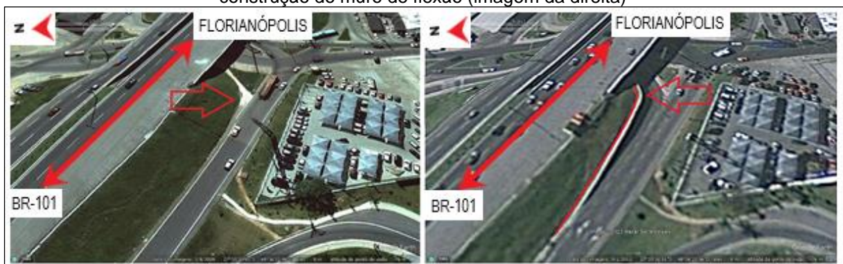
Figura 58: Imagem de satélite, do dia 08/01/2009, do trecho antes da execução do acesso (imagem da esquerda) e imagem de satélite, do dia 01/09/2011, do trecho após a execução do acesso e construção do muro de flexão (imagem da direita)
