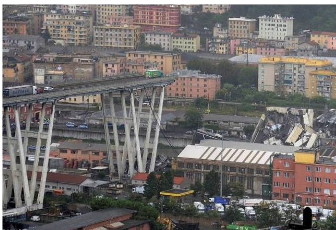
Figura 6 – Ponte Morandi - Itália
