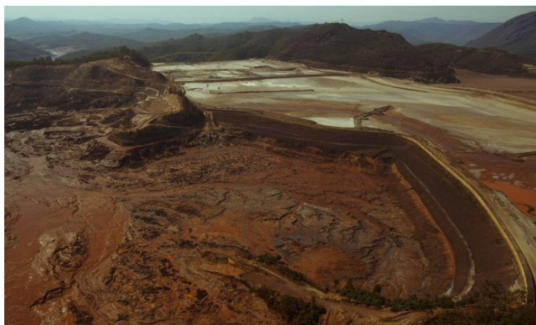
Figura 8 – Barragem do Fundão vazia a frente e barragem do Germano ainda cheia atrás - Mariana - MG
