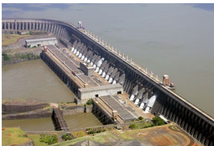
Figura 15 – Estrutura de concreto da Usina Hidroelétrica de Itaipu
